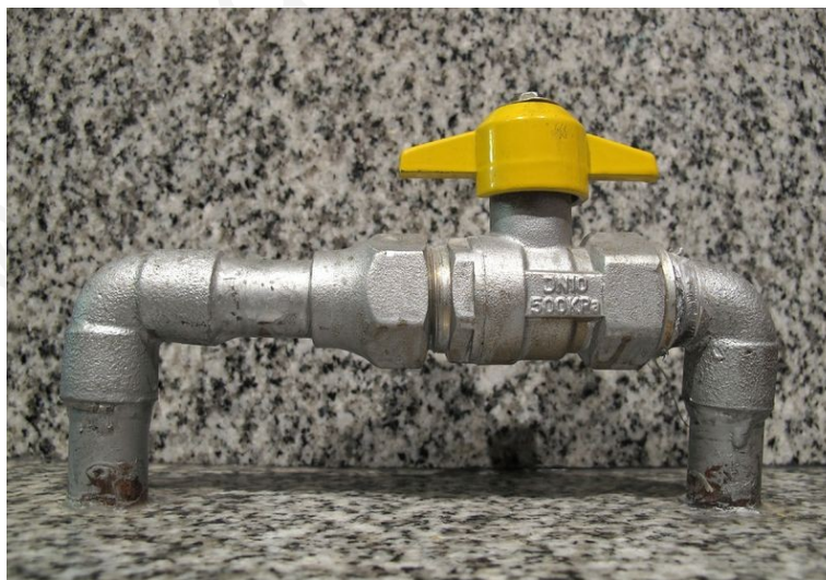
Llave de paso de Gas Natural en una cocina de Santiago de Chile.
