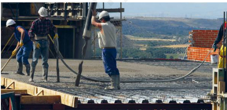
Vertido de hormigón en el forjado de un edificio
