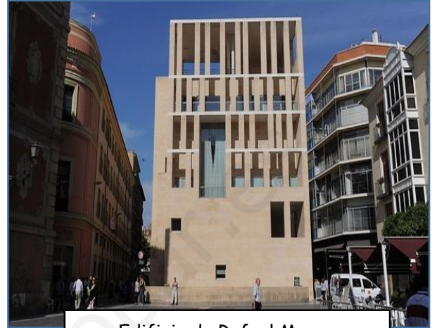
Edificio de Rafael Moneo (Anexo Ayuntamiento de Murcia)
