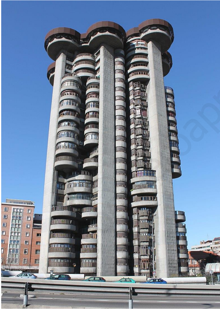
Francisco J. Sáenz de Oiza: Edificio Torres Blancas (1964), Madrid.
