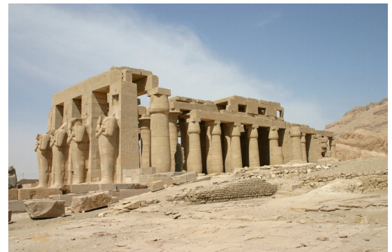
Las estructuras adinteladas se emplearon mucho en la antigüedad.
