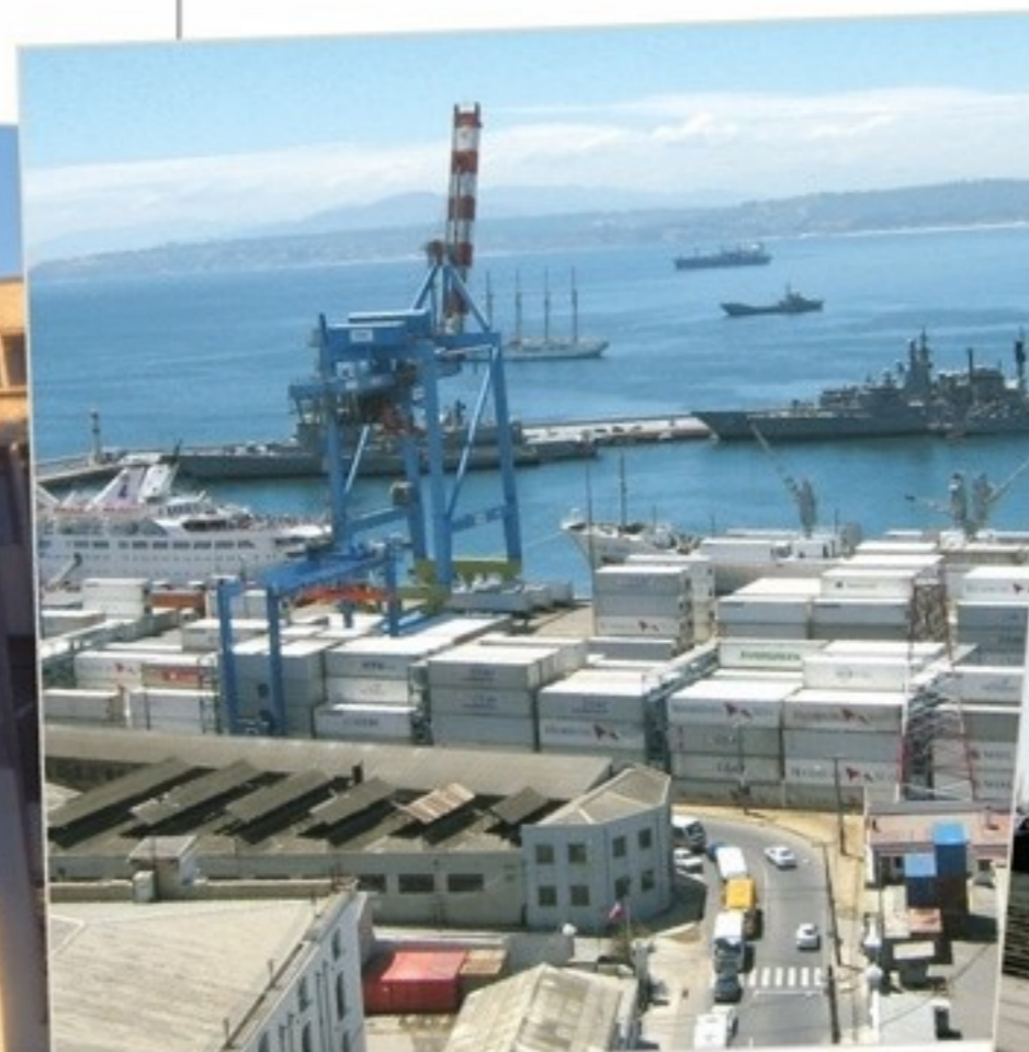
Molo de abrigo del puerto de Valparaíso.
