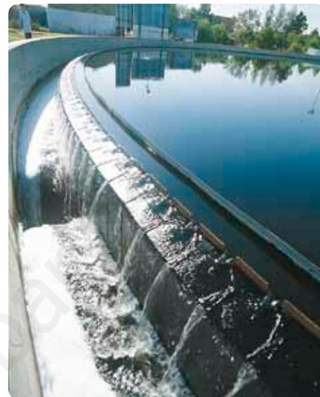
▲ Planta de tratamiento de aguas servidas.
