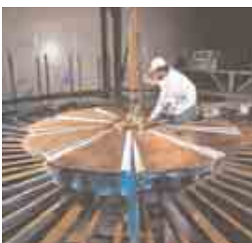
La fotografía muestra la instalación del SPEED 2.
