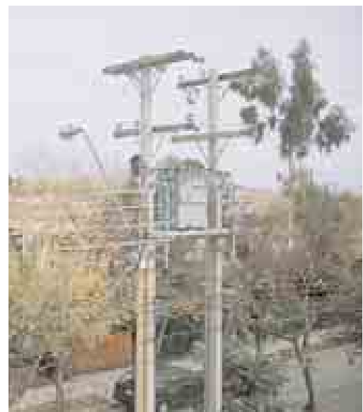
Los transformadores ubicados en el tendido eléctrico reducen o aumentan el voltaje de acuerdo a las necesidades de utilización.
