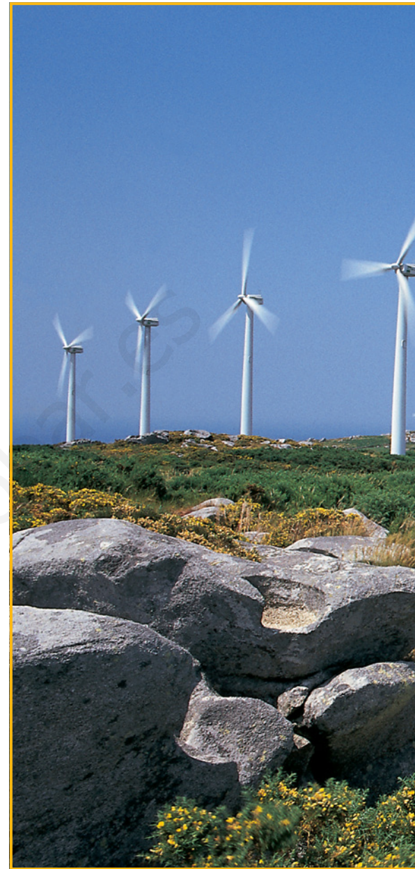
▶ Parque eólico en Malpica (A Coruña).
