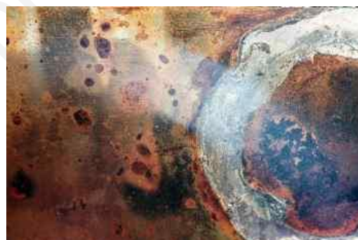
Lámina de metal oxidado
