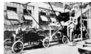
Cadena de montaje de automóviles Ford T.
