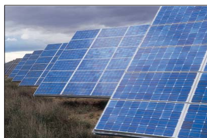
CENTRAL DE PLACAS SOLARES
