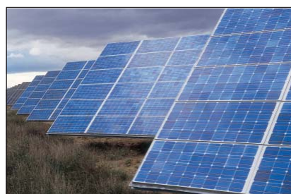
CENTRAL DE PLACAS SOLARES
