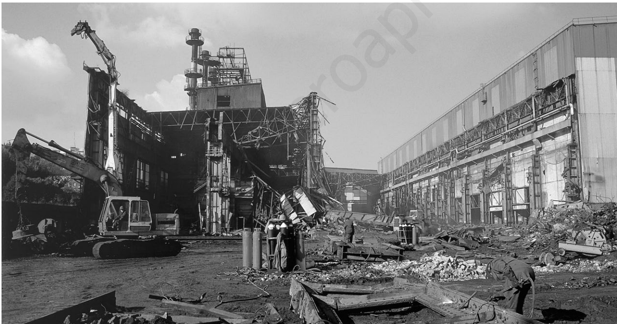
Desmantelamiento de las instalaciones de Altos Hornos de Vizcaya.
