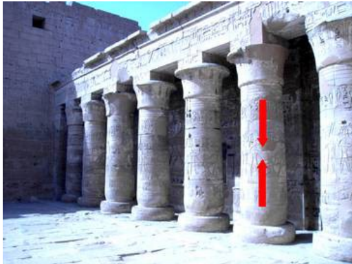
Los pilares soportan el esfuerzo de compresión
