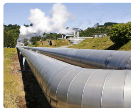
captación de aguas
